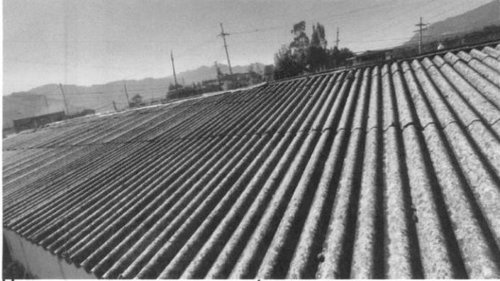
FOTO 1: ESTADO ACTUAL DE LAS LÁMINAS A CAMBIAR EN AULAS
