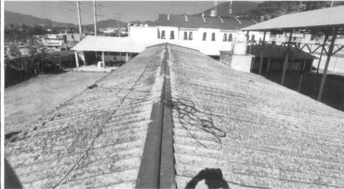
FOTO 3: ESTADO ACTUAL DE LA LÁMINA A CAMBIAR EN AULAS
