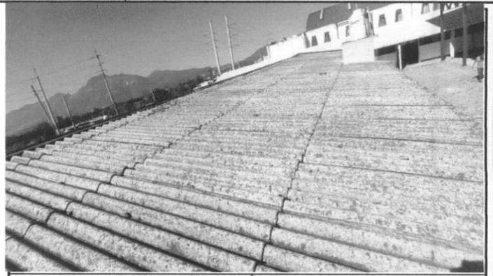
FOTO 2: ESTADO ACTUAL DE LAS LÁMINAS A CAMBIAR EN AULAS
